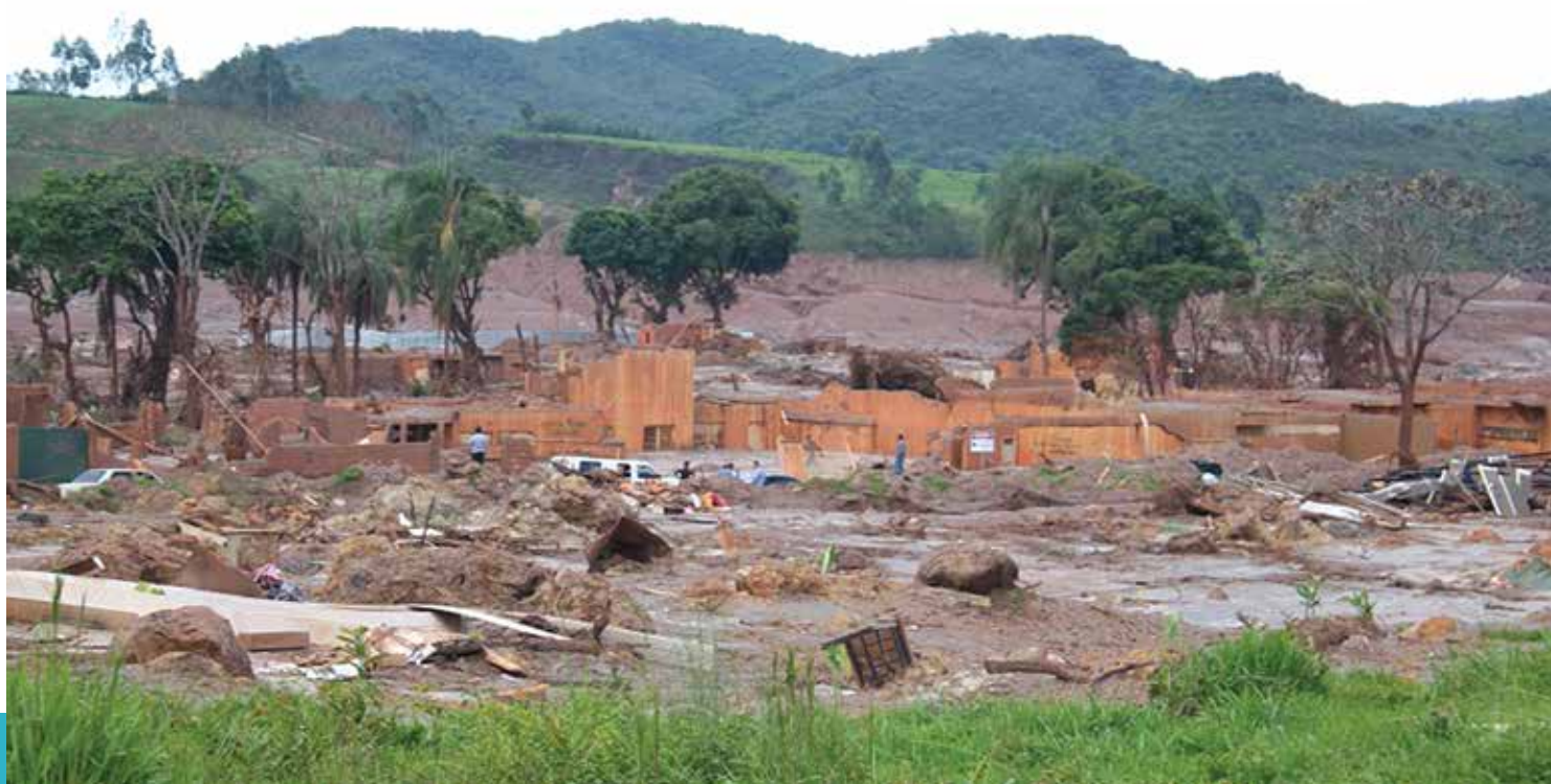
Cenário de destruição: o que restou de Bento Rodrigues após o rompimento da barragem de Fundão
